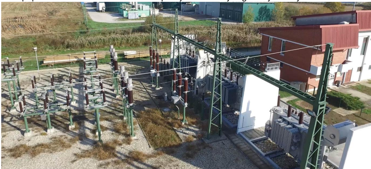
Slika 1: RTP Lendava - prazno 110 kV TR3 polje, ki ga je potrebno urediti
