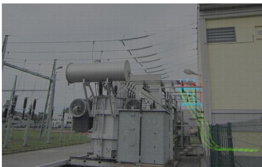
Slika 4: RTP Ptuj - predvideno stanje – povezava 20 kV TR1 in TR2 z zbiralkami (podrobneje)
