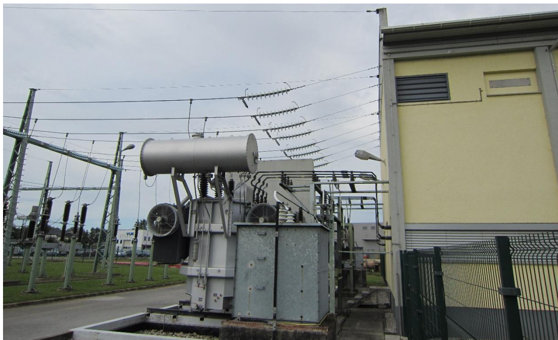
Slika 3: RTP Ptuj - obstoječe stanje – povezava 20 kV TR 1 in TR 2 z zbiralkami
